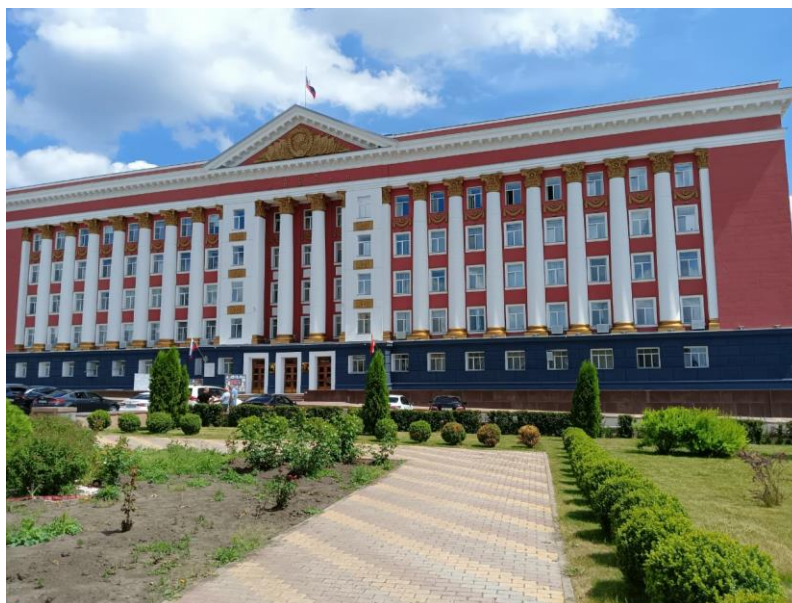
Фото 1. Объект культурного наследия регионального значения «Дом Советов» 1939-1951 г.г. Главный фасад здания.
