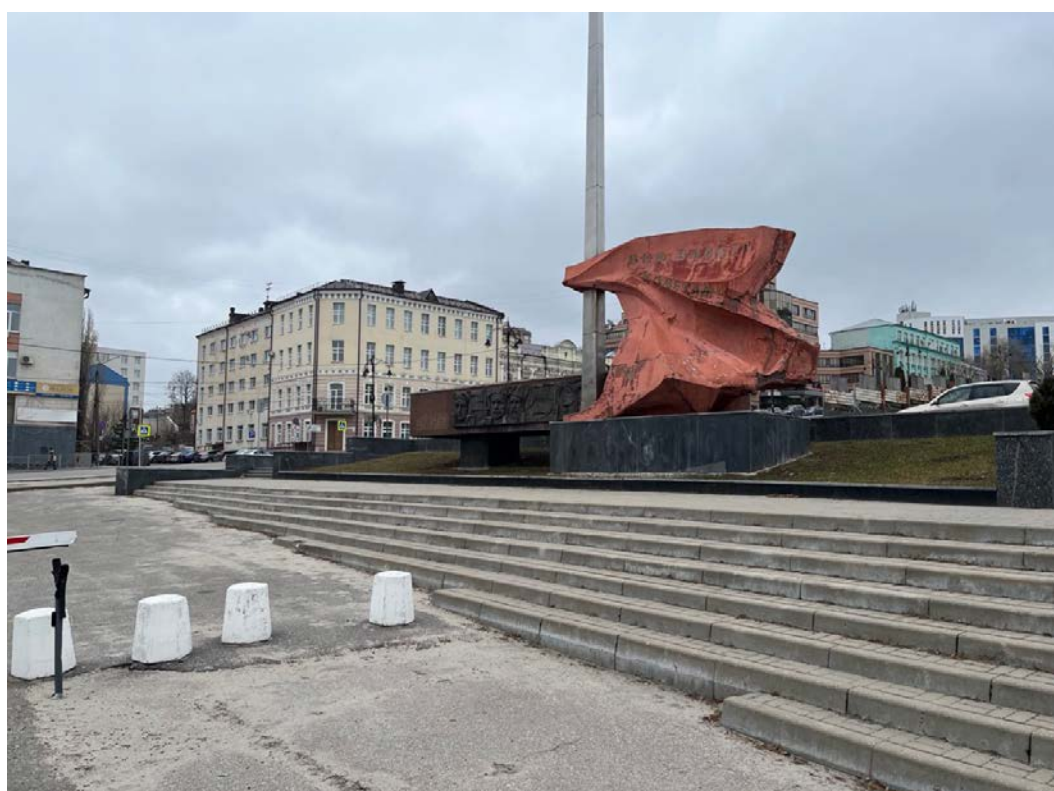
Фото 2. Общий вид Объекта с юго-западной стороны.
