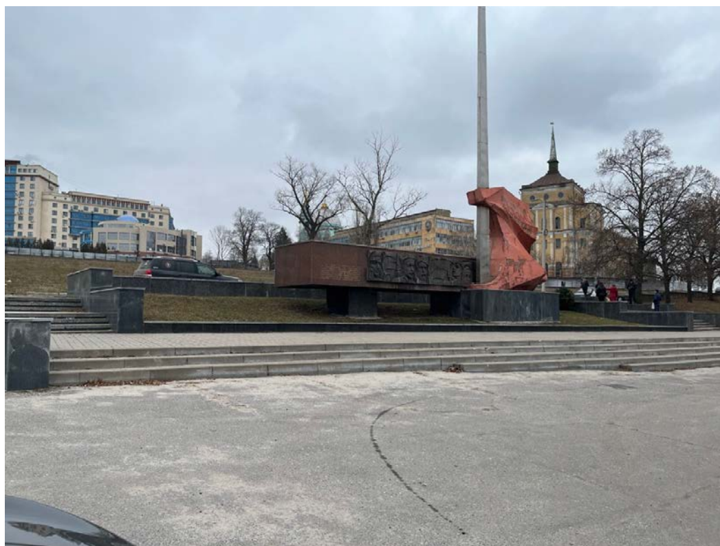
Фото 1. Общий вид Объекта с северо-западной стороны.
