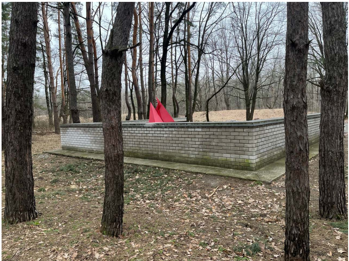
Фото 4. Общий вид Объекта с северной стороны.
