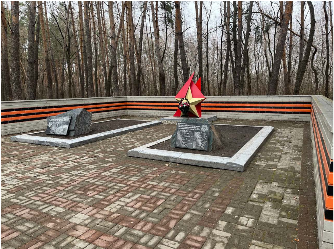
Фото 3. Общий вид Объекта с южной стороны.
