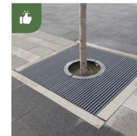
Решетка установлена в уровень мощения, есть приподнятый каркас, который защищает почву от уплотнения, проложен автополив.
