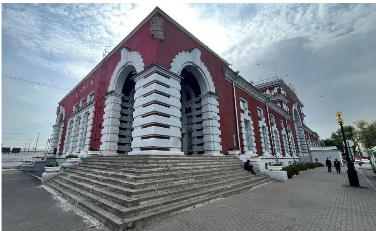
Фото 2. Общий вид Объекта с северо-западной стороны.
