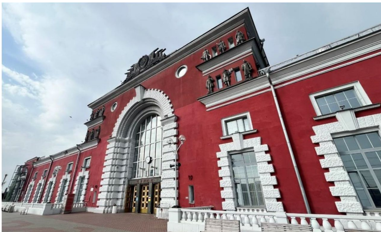
Фото 1. Общий вид Объекта со стороны восточного фасада.
