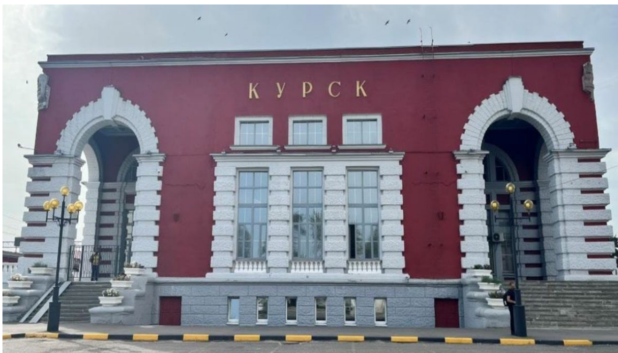
Фото 3. Общий вид Объекта со стороны северного фасада.
