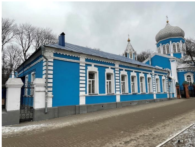
Фото 2. Объект культурного наследия регионального значения «Здание церковно-приходской школы» кон. XIX – нач. XX вв. Главный фасад.
