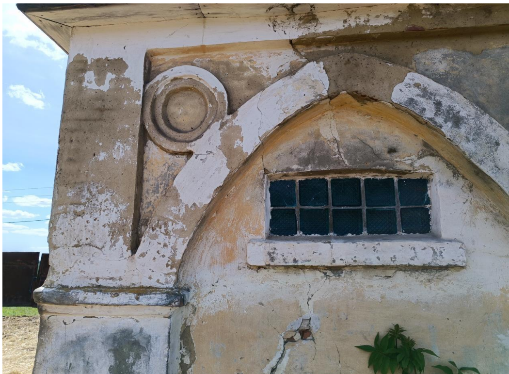
Фрагмент северного фасада. Декор восточного крыла
