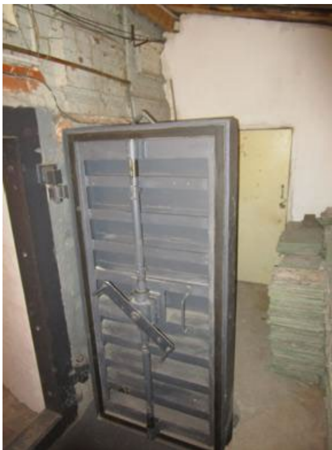
Фото 4. Интерьеры подвала Объекта. Входная дверь в укрытие.
