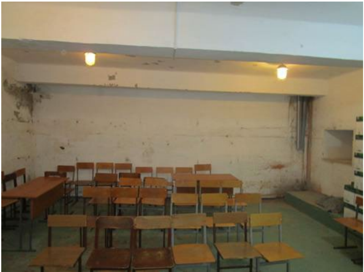
Фото 5. Интерьеры подвала Объекта.
