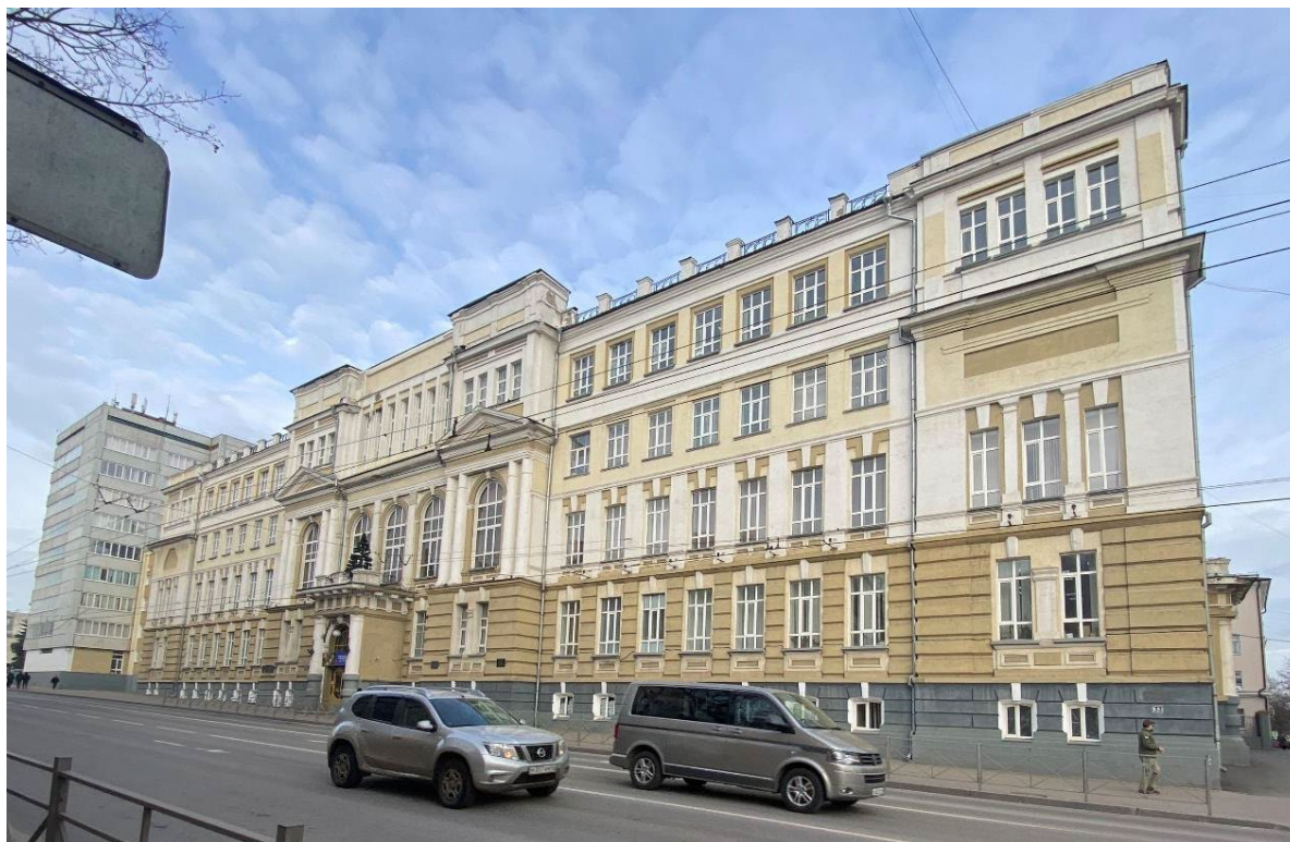
Фото 1. Общий вид Объекта со стороны главного (западного) фасада.
