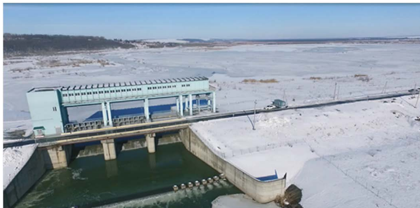
Рис. 15.31. Гидроузел Курского водохранилища
