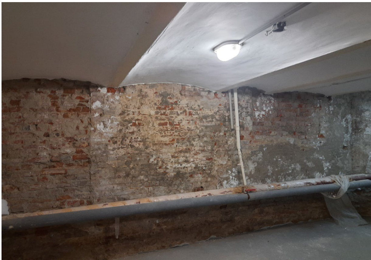
Фото 5. Интерьеры Объекта. Помещение подвала.
