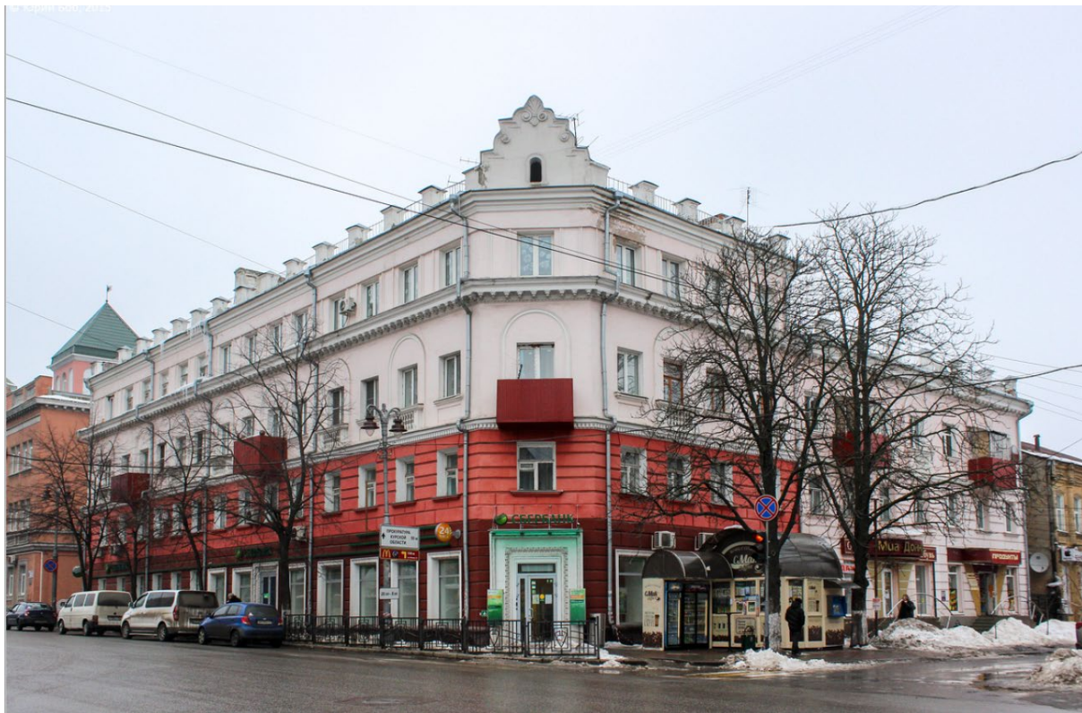
Фото 1. Общий вид Объекта с пересечения ул. Ленина, Кирова и Уфимцева.
