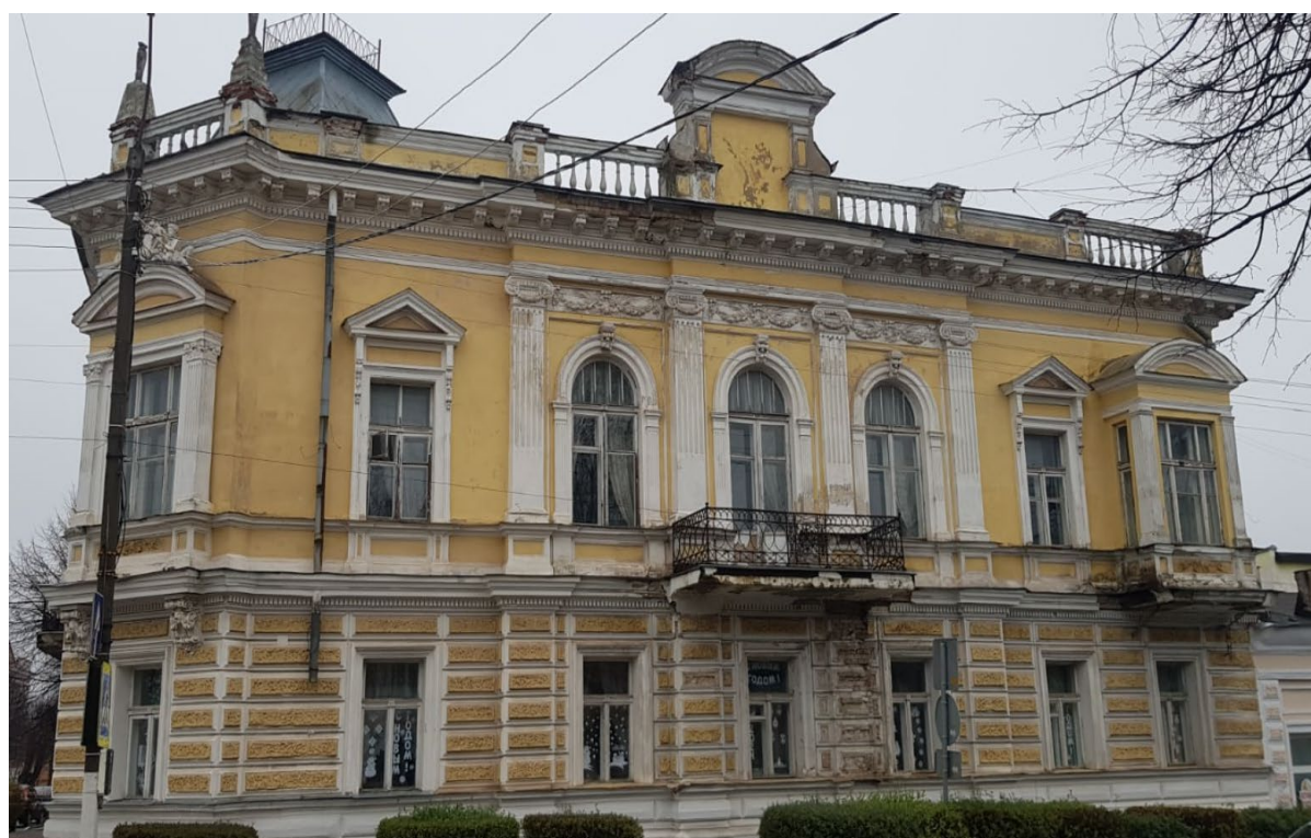
Фото 2. Общий вид Объекта со стороны южного фасада.
