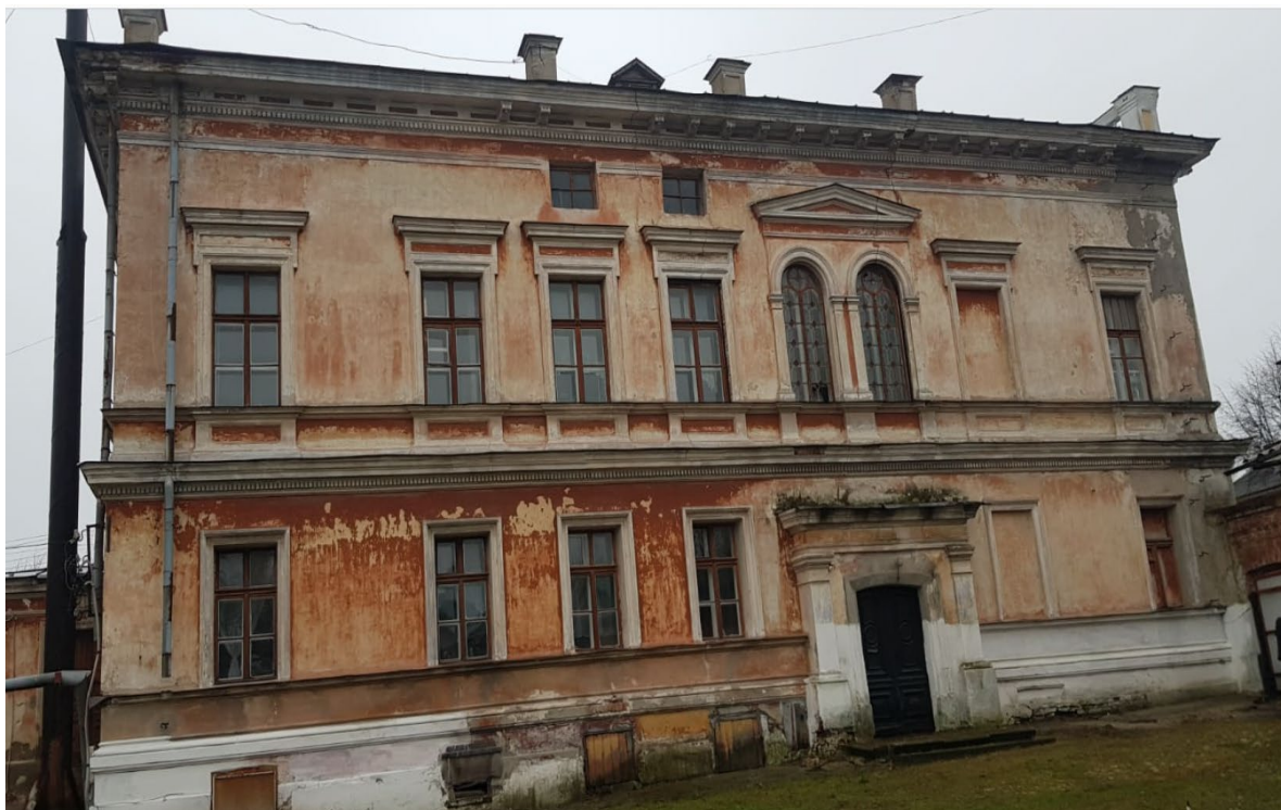
Фото 3. Общий вид Объекта со стороны северного фасада.
