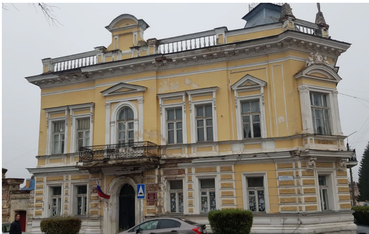
Фото 1. Общий вид Объекта со стороны западного фасада.
