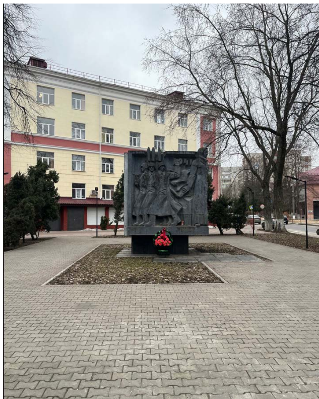
Фото 1. Общий вид Объекта с восточной стороны.
