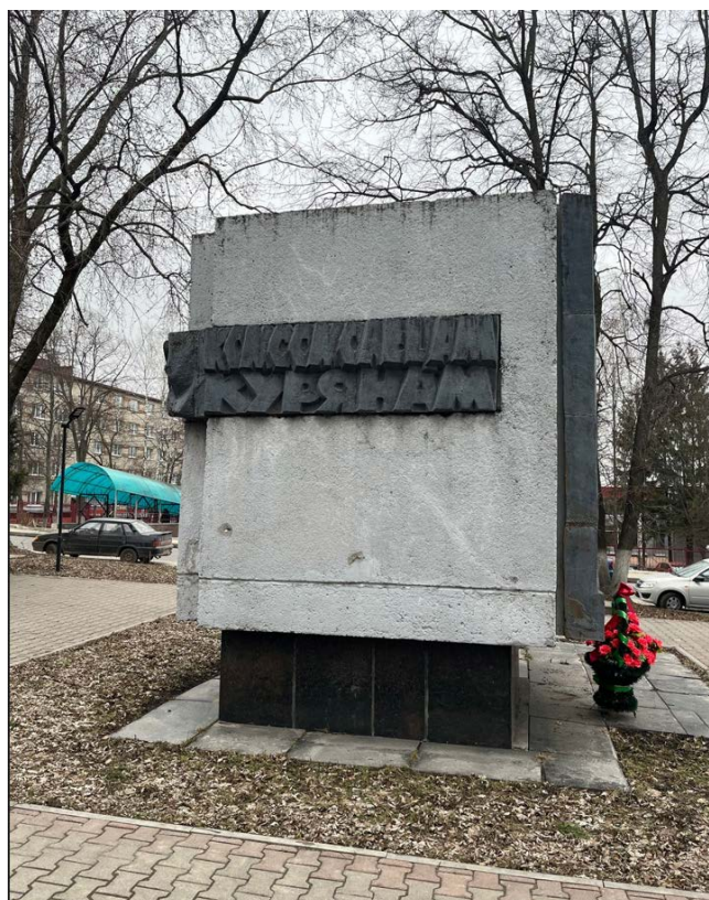
Фото 2. Общий вид Объекта с южной стороны.
