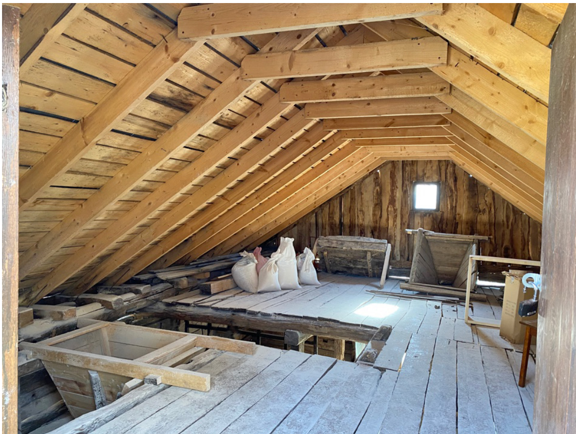
Фото 6. Чердачное помещение мельницы.
