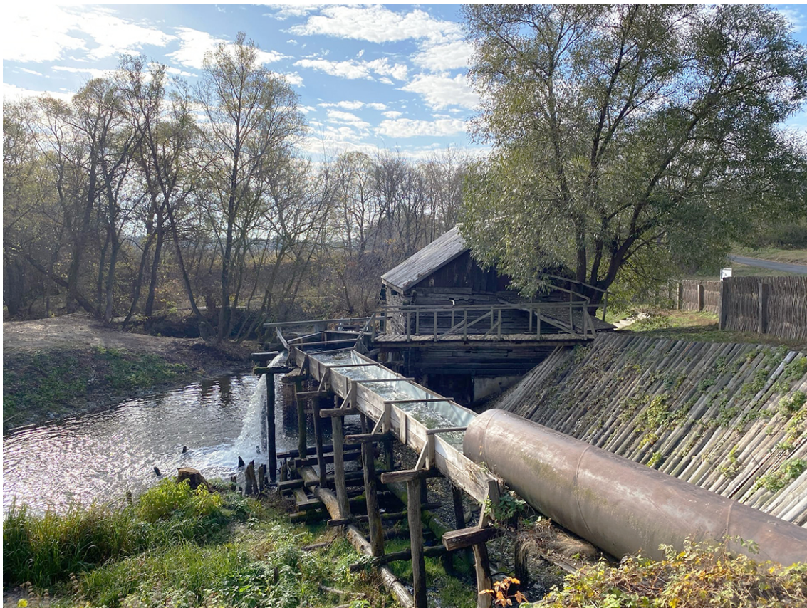
Фото 3. Северный фасад мельницы.
