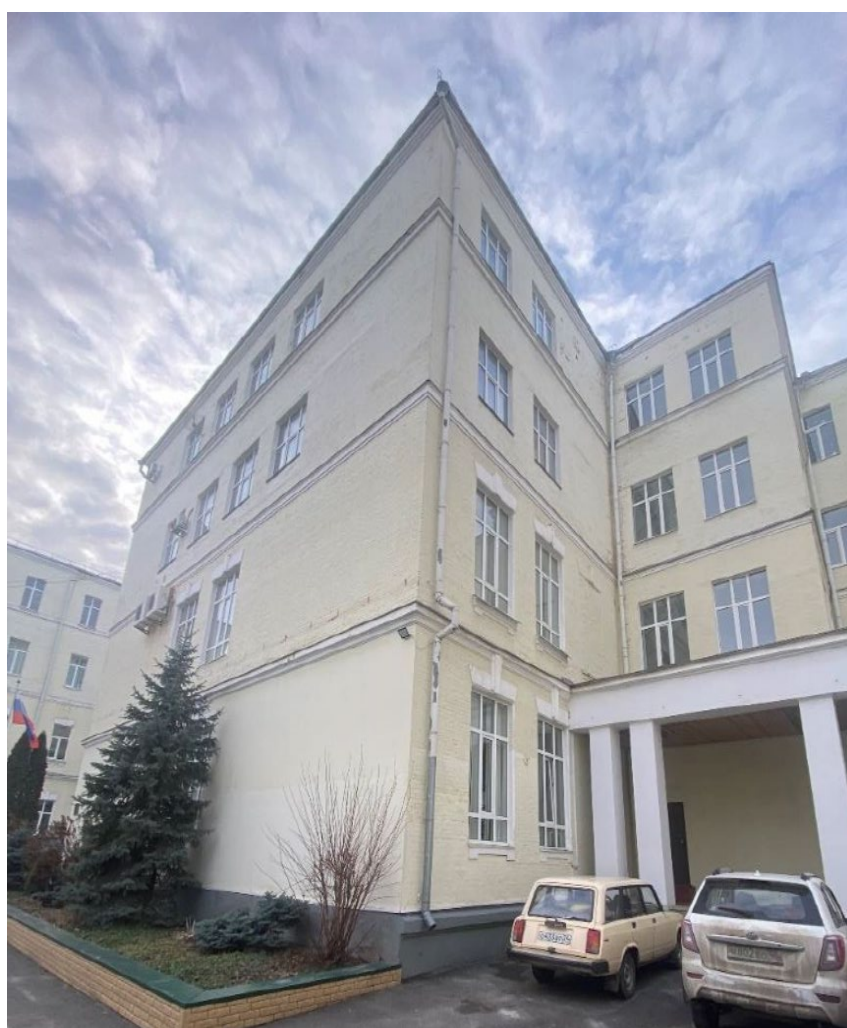
Фото 4. Фрагмент дворового (восточного) фасада Объекта.
