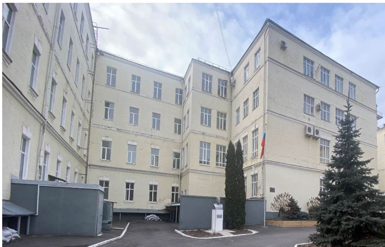
Фото 2. Фрагмент дворового (восточного) фасада Объекта.
