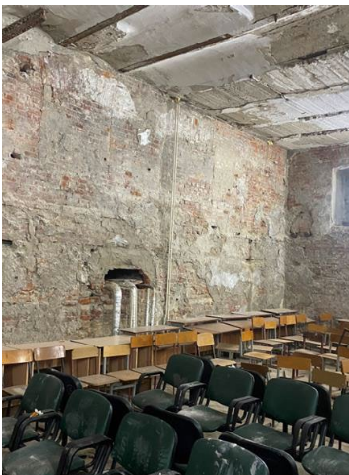
Фото 6. Интерьеры подвала Объекта.
