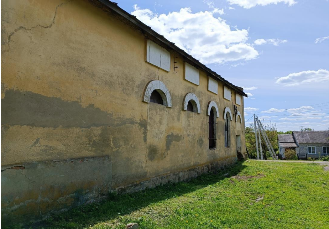
Фото. Хозяйственный корпус. Общий вид западного фасада
