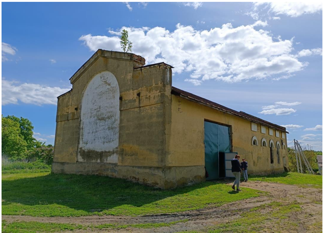
Фото. Хозяйственный корпус. Общий вид с северо-западного угла
