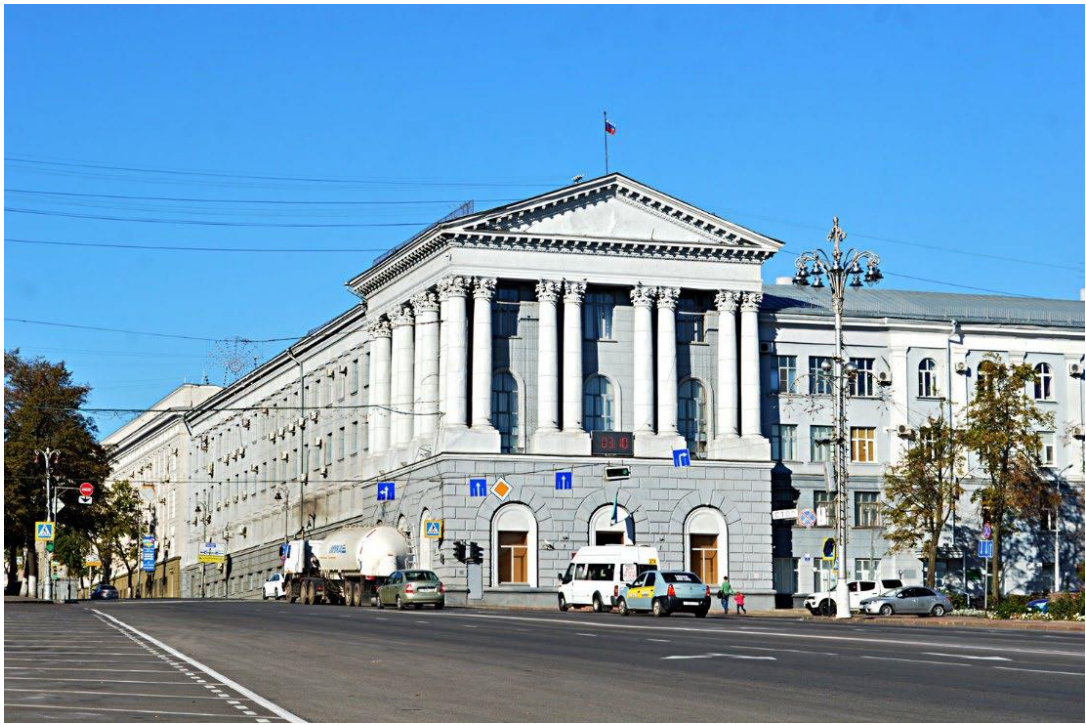
Фото 1. Объект культурного наследия регионального значения «Здание Горсовета». г. Курск, ул. Ленина, д. 1.
