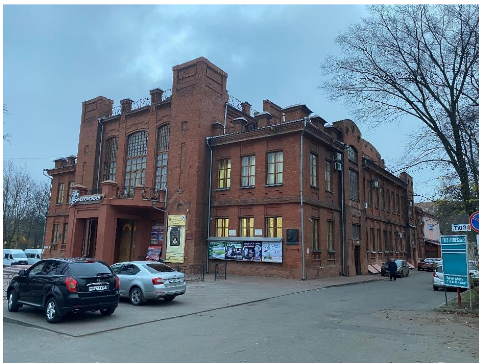
Общий вид здания.
