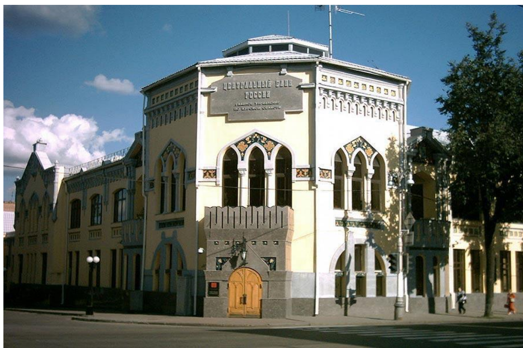
Здание банка после реконструкции в 2001 году.
