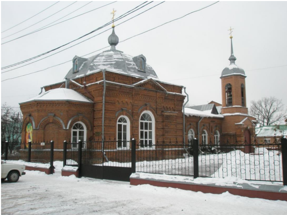
Фото октябрь-ноябрь 2023 года. Фасад со стороны ул. Полевой
