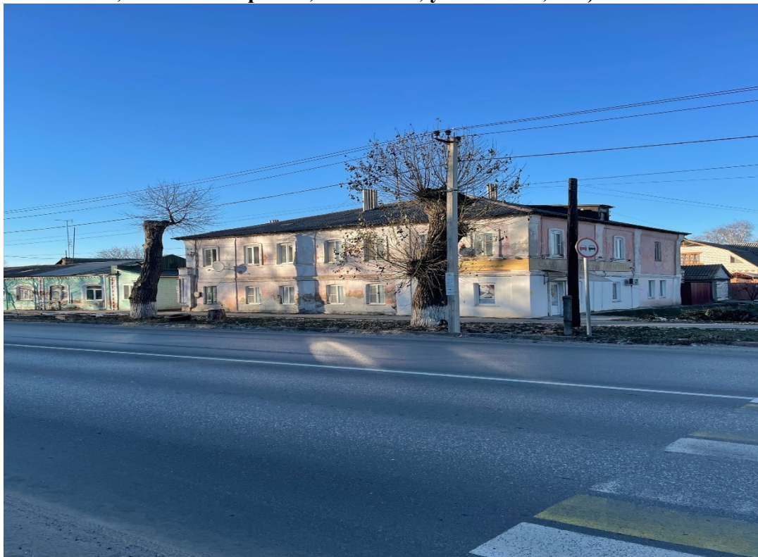
Рис. 2. Выявленный объект культурного наследия «Дом жилой, кон. XIX - нач. XX вв. (Курская область, Обоянский район, г. Обоянь, ул. Ленина, 105)».. Фото декабрь 2022 г.
