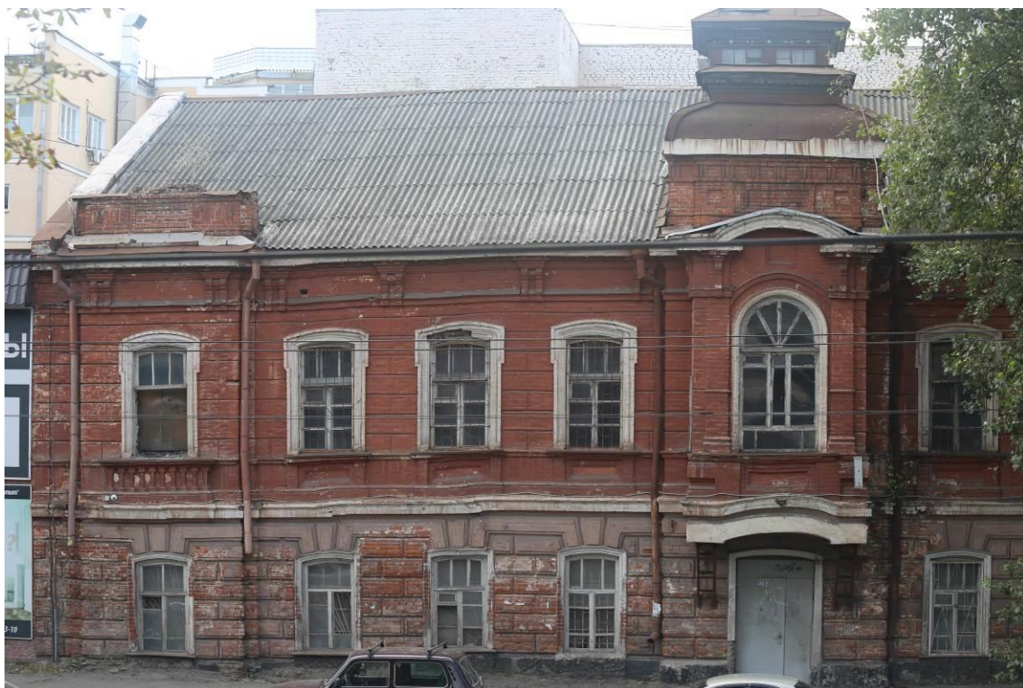
Фото 1. Фрагмент главного фасада со стороны ул. Александра Невского.
